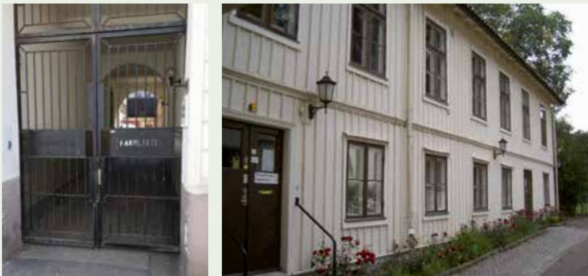
Vänster: Gamla FFG-porten på Vallgatan. Höger: FFGs lokaler på Södra vägen 61.
